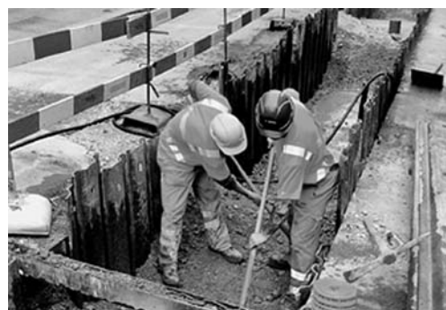
Bild 2: Sehr schwere Arbeiten sind auf die frühen Morgenstunden zu verlegen.
