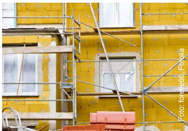
Abb. 1: Dämmung mit Mineralwolle.
