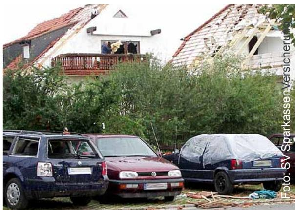
Abgedeckte Ziegel und zerbrochene Fenster durch Sturm.
