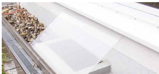
Abb. 2: Drainage, erhöhter Sockel um Lichtschacht
