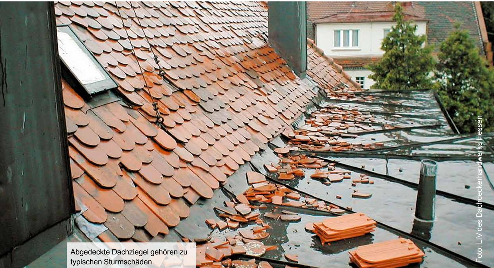
Abgedeckte Dachziegel gehören zu typischen Sturmschäden.
