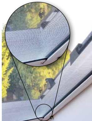
Abb. 1: Dachfenster mit Fliegengitter.
