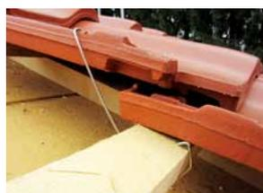
Abb. 3: Ziegelverklammerung: die Dichte der Verklammerung steigt mit erwarteter Windlast.
