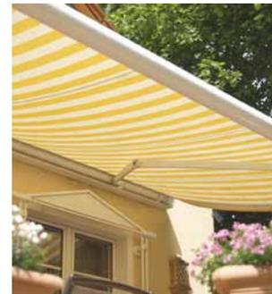
Abb. 2: Verschattung von außen, z. B. durch Markisen, wirkt einer Überhitzung der Innenräume entgegen.
