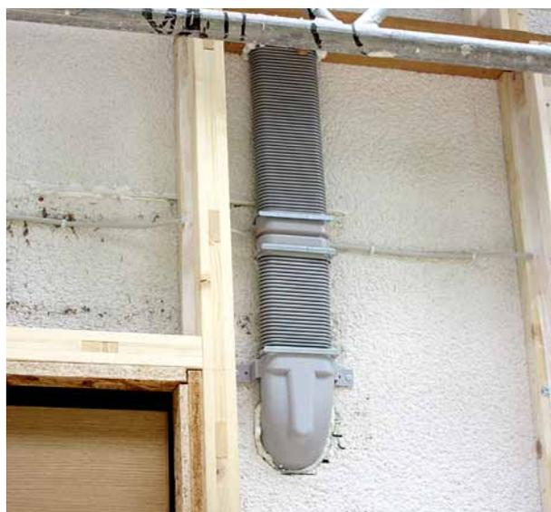
Abb. 1: Beispiel Lüftungskanal an der Außenfassade.
