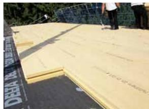
Abb. 1: Die Aufdachdämmung bietet den effektivsten Schutz vor Hitze und Kälte.
